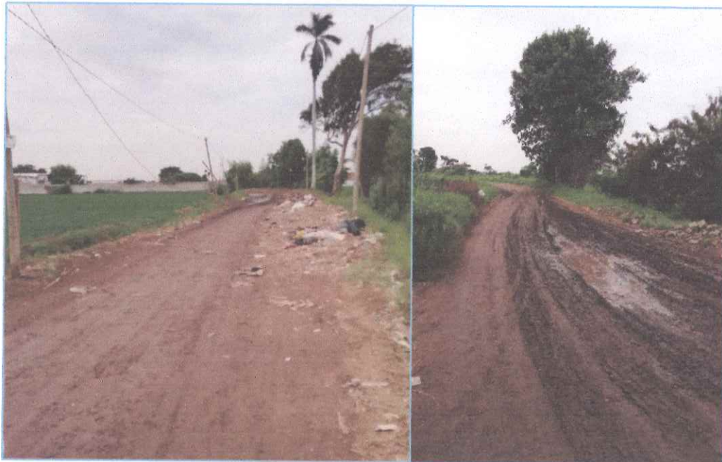
IMAGEN 171: ESTADO ACTUAL DE LOS CAMINOS VECINALES
