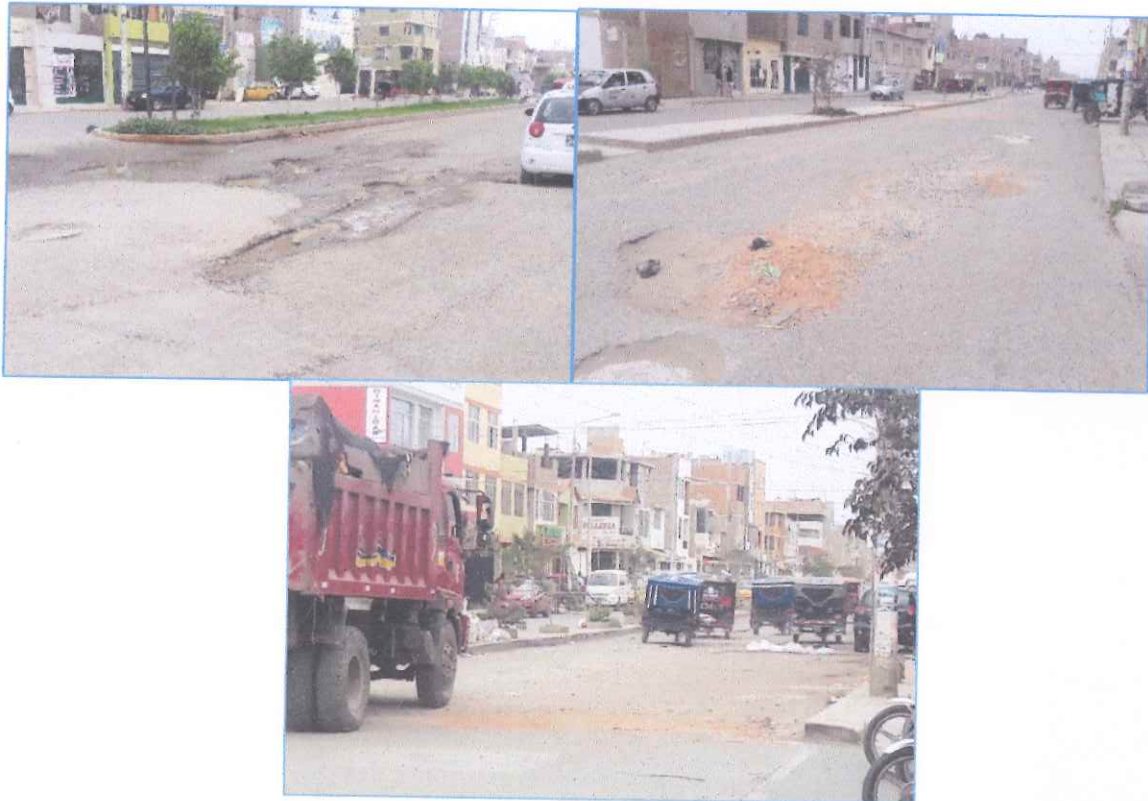
IMAGEN 5: PISTAS EN MAL ESTADO
